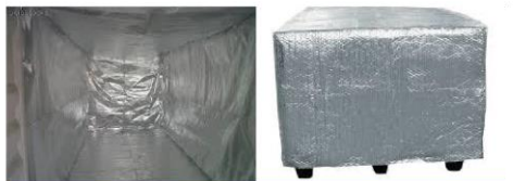
Instalación manta térmica
